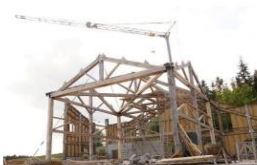
11 Avril 2019 Etat du chantier
