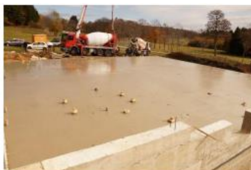
5 Nov.2018. Coulage de la dalle
